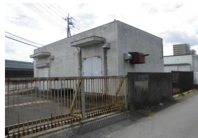
逆西中継ポンプ場
