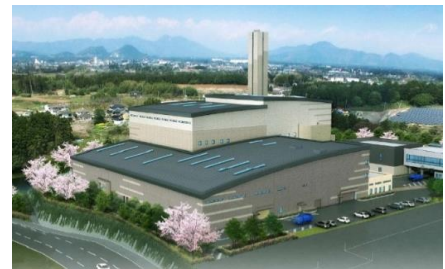
霞台厚生施設組合の新ごみ処理施設外観
