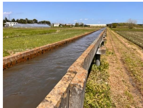
出島用水水路(戸崎原地内)
