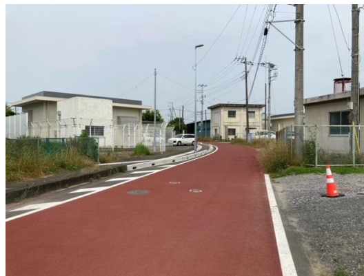
R2国補(三次補正)市道8-0455号線道路改良工事完了写真
