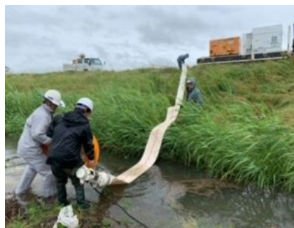
◀令和5年台風2号の影響により内水被害を受けた田伏地内における排水作業の様子（霞ヶ浦河川事務所排水ポンプ車協力）
