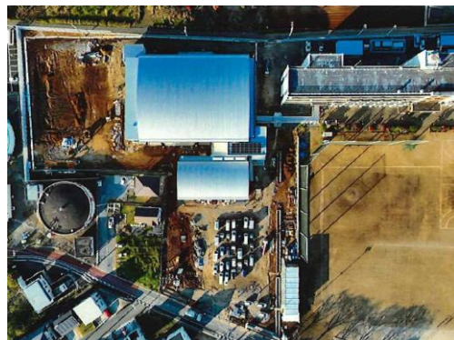
下稲吉中学校外構工事予定地
