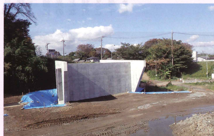
▲市川地区改良工事
