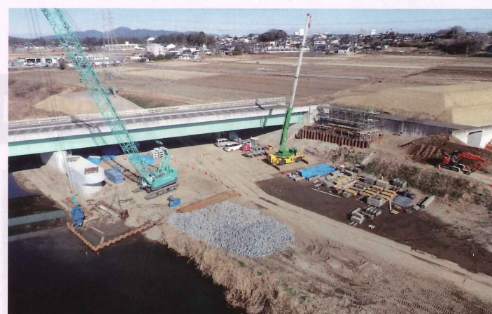
▲恋瀬橋下部工事
