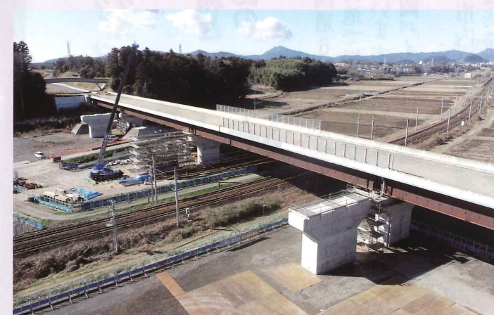
▲東田中高架橋下部工事
