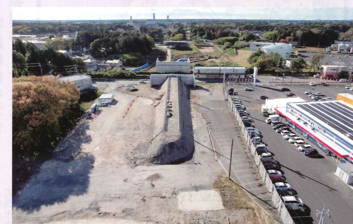
▲玉里高架橋上部工事
