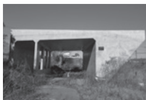
▲千代田石岡バイパス橋梁（市川地内）
