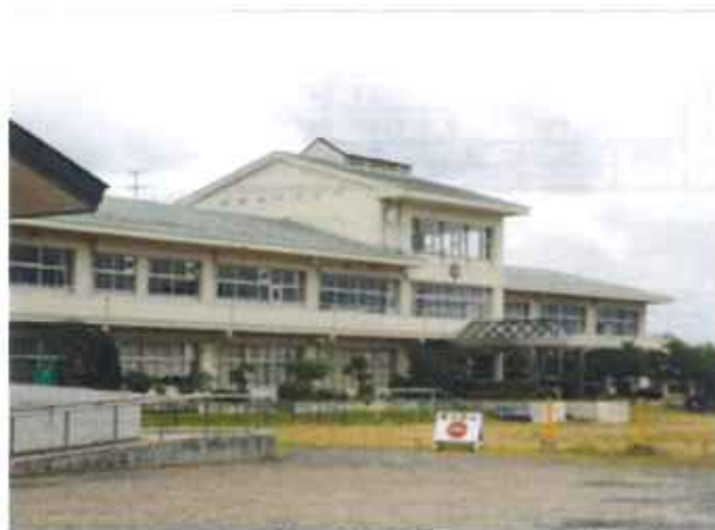
日本語学校に改修される旧大崎市立西古川小学校 =2023年6月8日午後4時17分、宮城県大崎市、根津弥撮影
