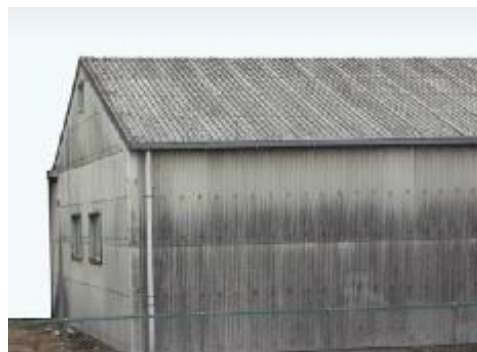
石綿含有スレート波板（屋根・外壁）
