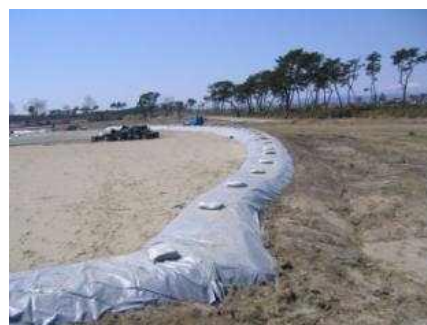
遮水シートを敷設した仮置場の事例 出典：仙台市ホームページ
