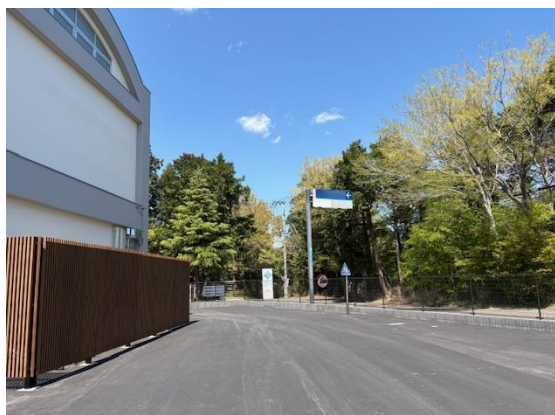
【改修後の駐車スペース】
