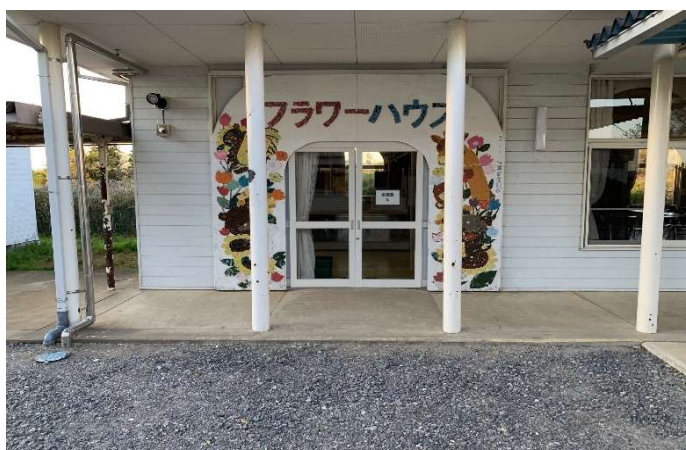
会議室 A(元・ランチルーム)
