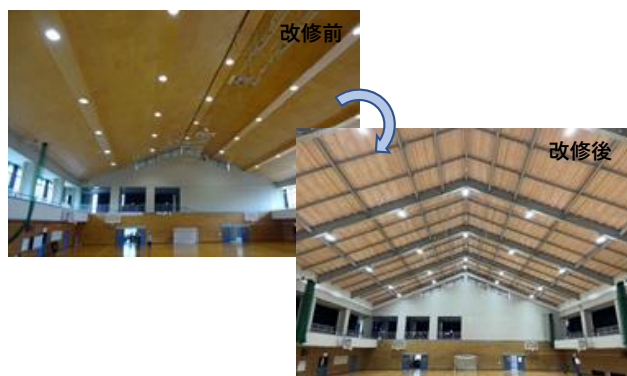
【千代田義務教育学校体育施設非構造部材耐震対策工事】
